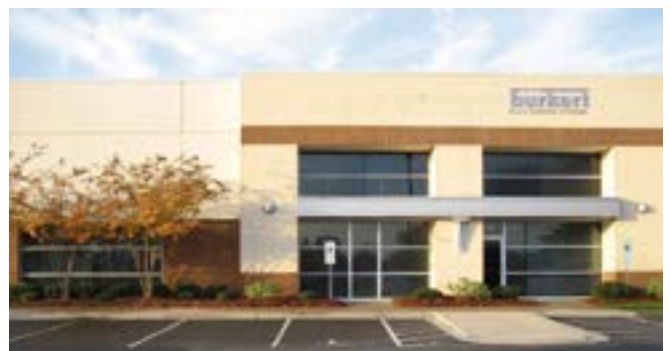
Systemhaus Charlotte | USA
